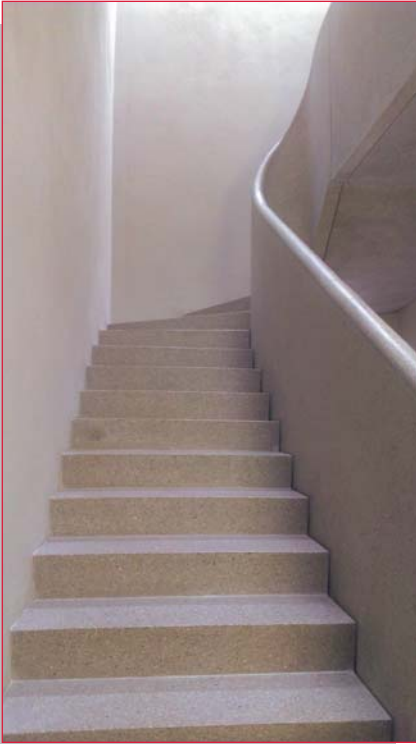
Büro Sauerbruch Hutton, Berlin Sauerbruch Hutton Generalplanungsgesellschaft mbH, Berlin
