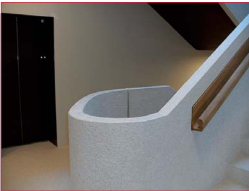
Bürogebäude GHU, Köln Sauerbruch Hutton Generalplanungsgesellschaft mbH, Berlin
